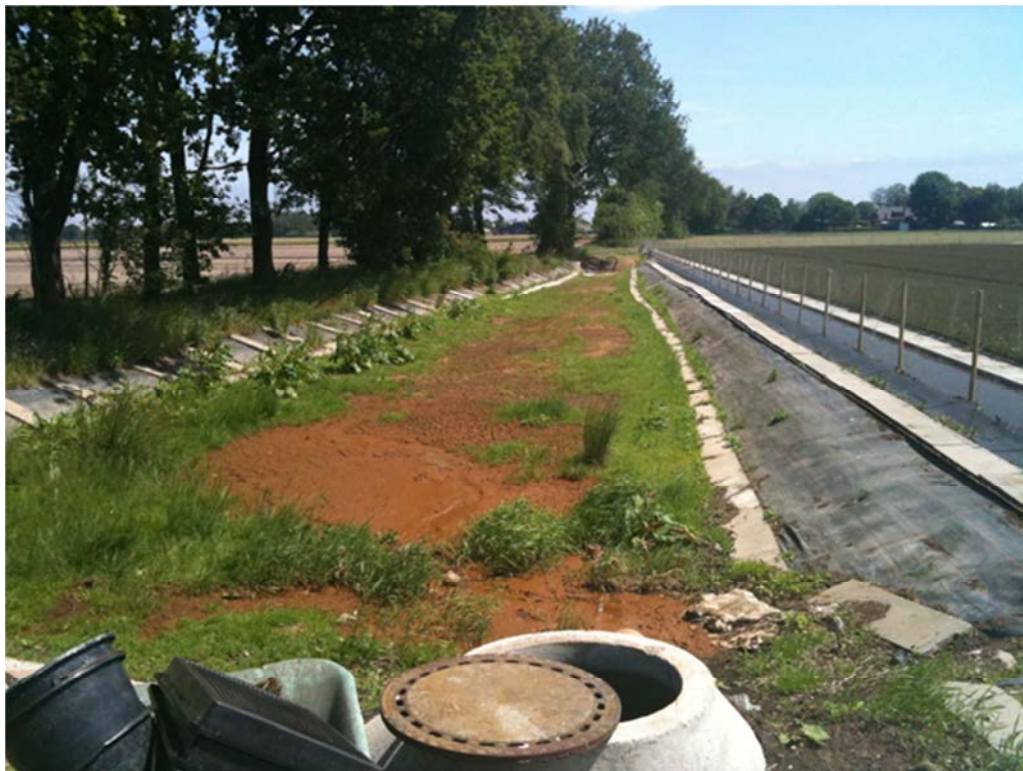
Abbildung 3: Versickerungsmulde im ursprünglichen Zustand (Sommer 2011).
