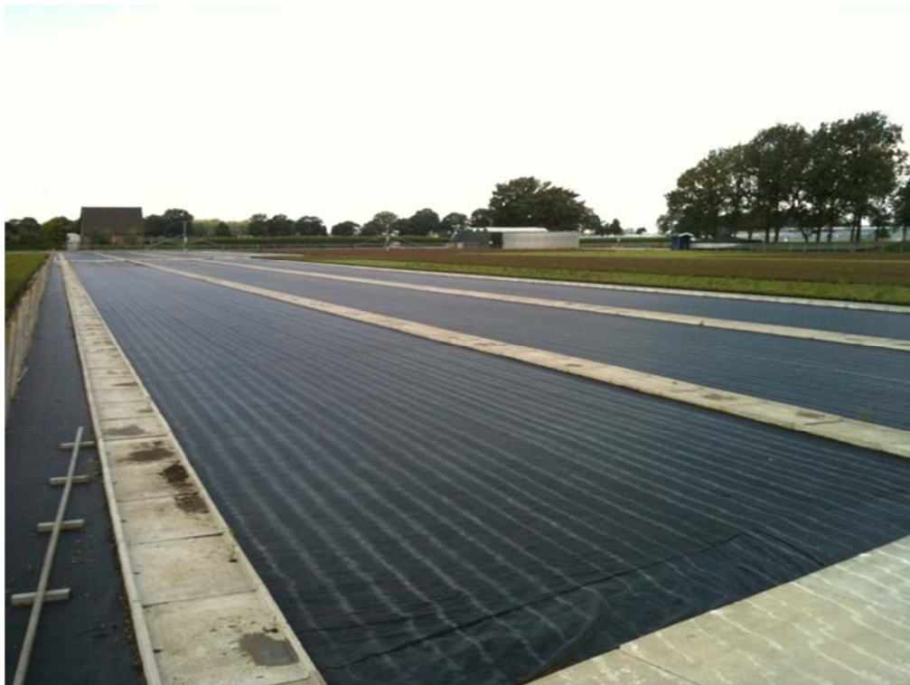
Abbildung 2: Blick auf die teilweise vorbereitete Stellfläche.
