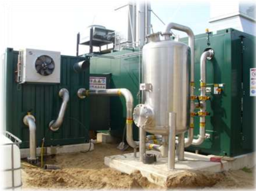
Aktivkohlefilter zur Entschwefelung
