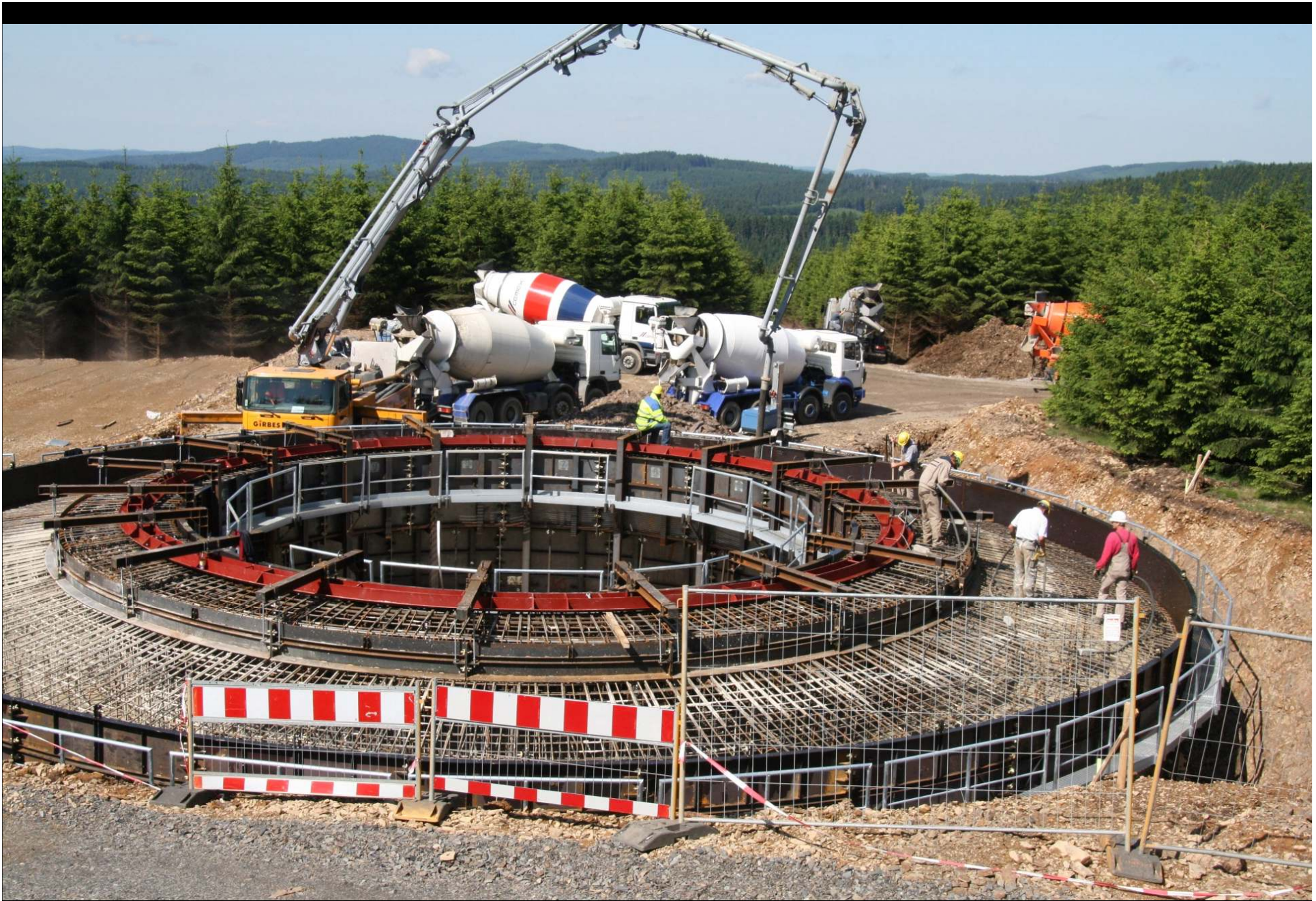
Fundamentguss
