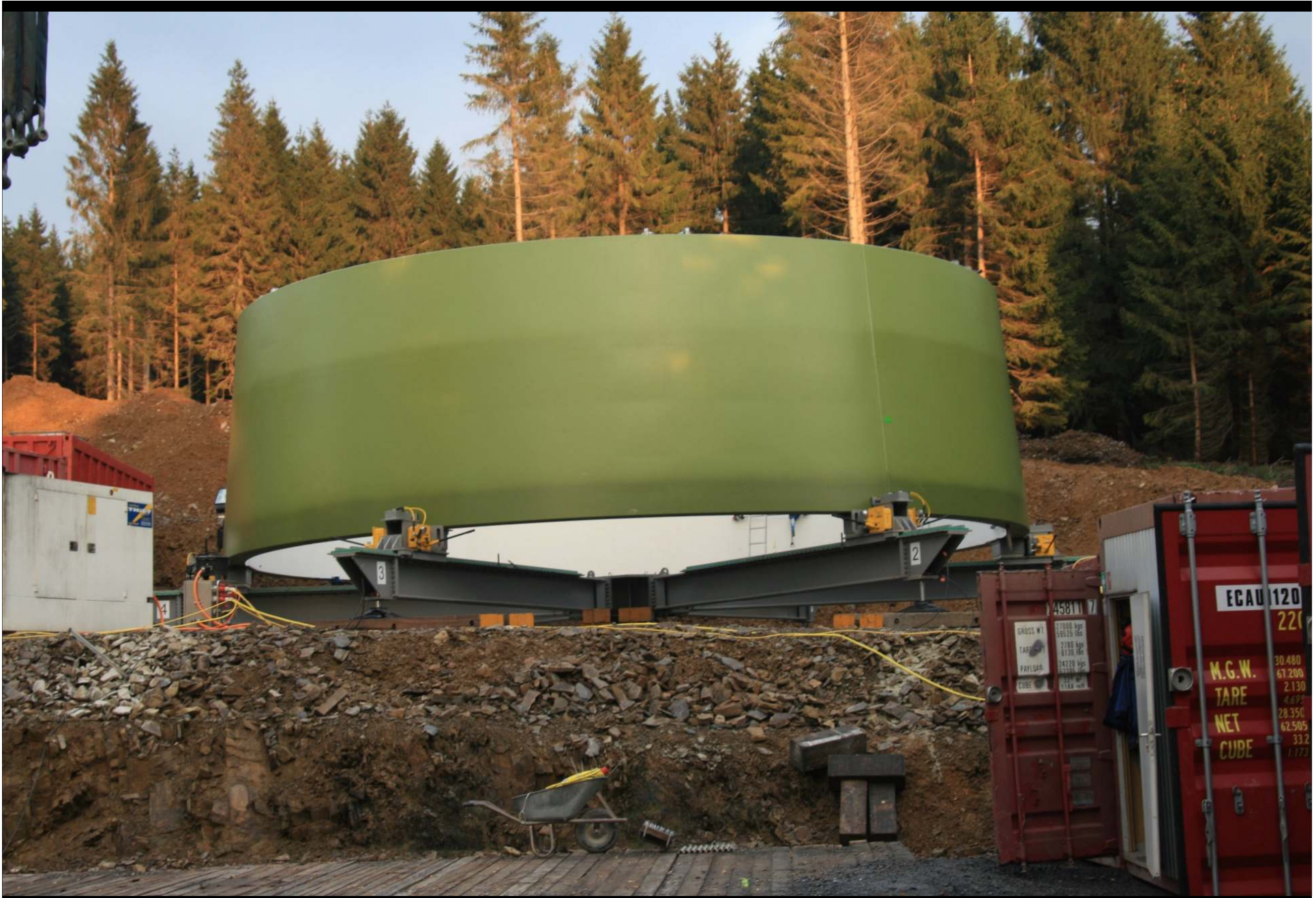
Verkleben eines Ringsegmentes auf dem Montagekreuz
