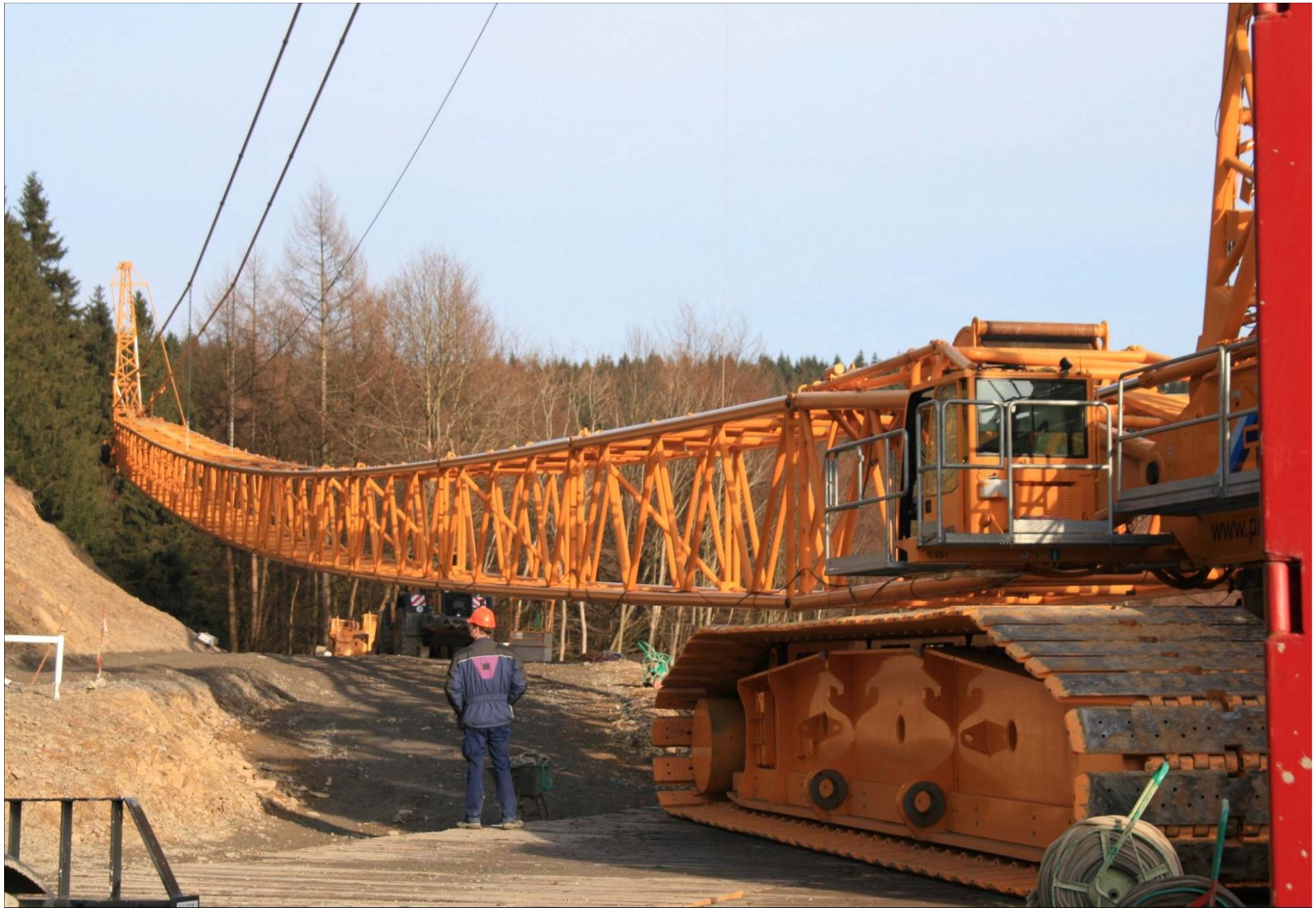
Beim Aufrichten biegt der Ausleger einige Meter durch
