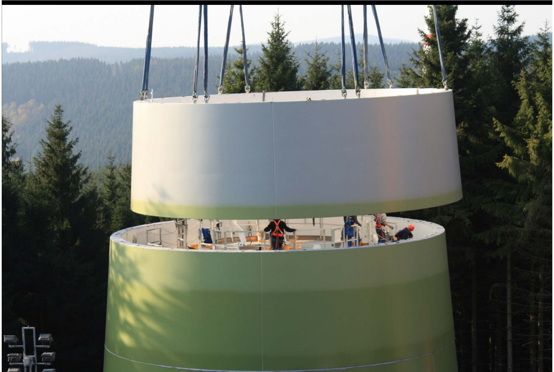
Ein Ringsegment wird gesetzt
