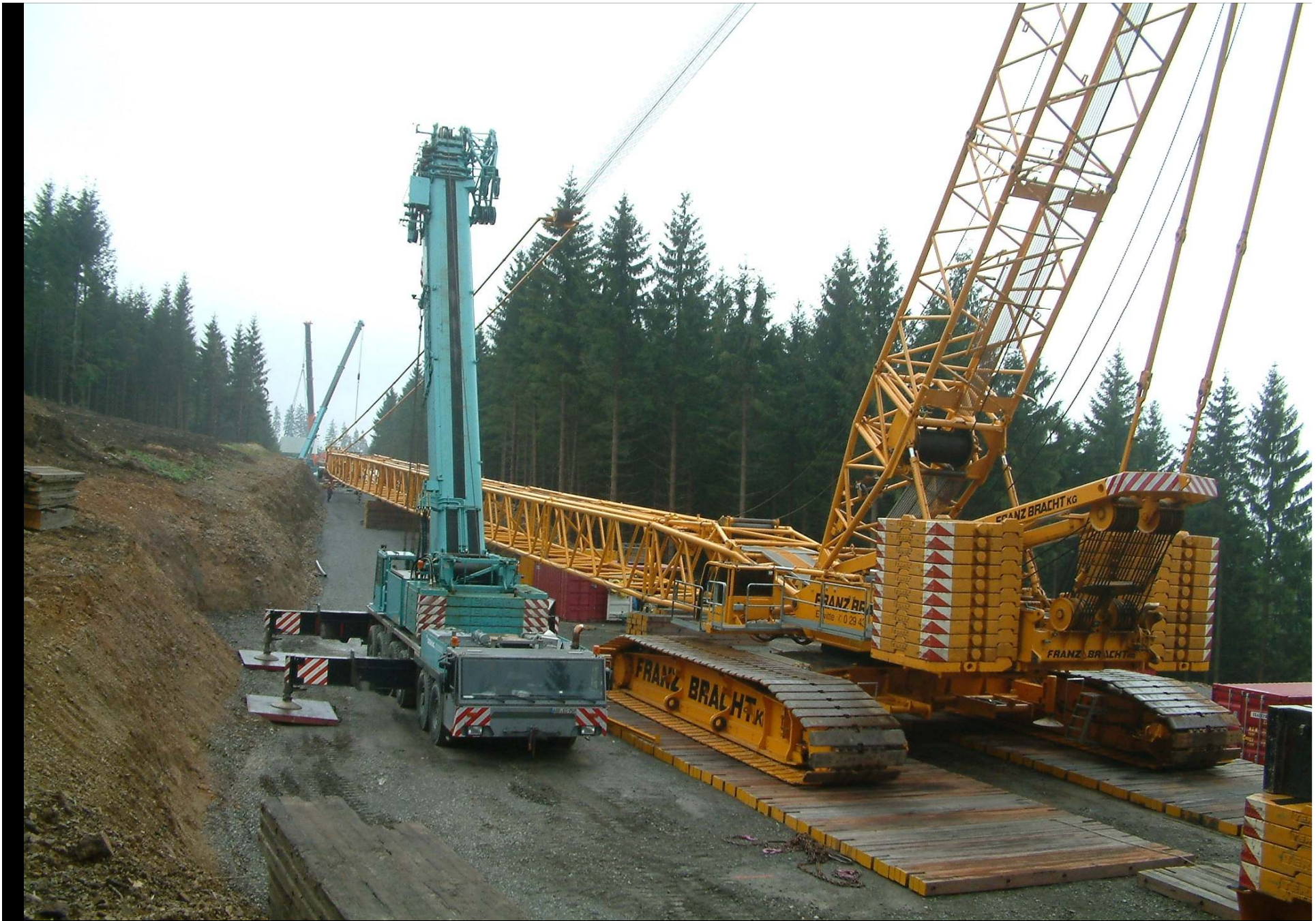
DEMAG-Kranraupe und „Servicekrane“
