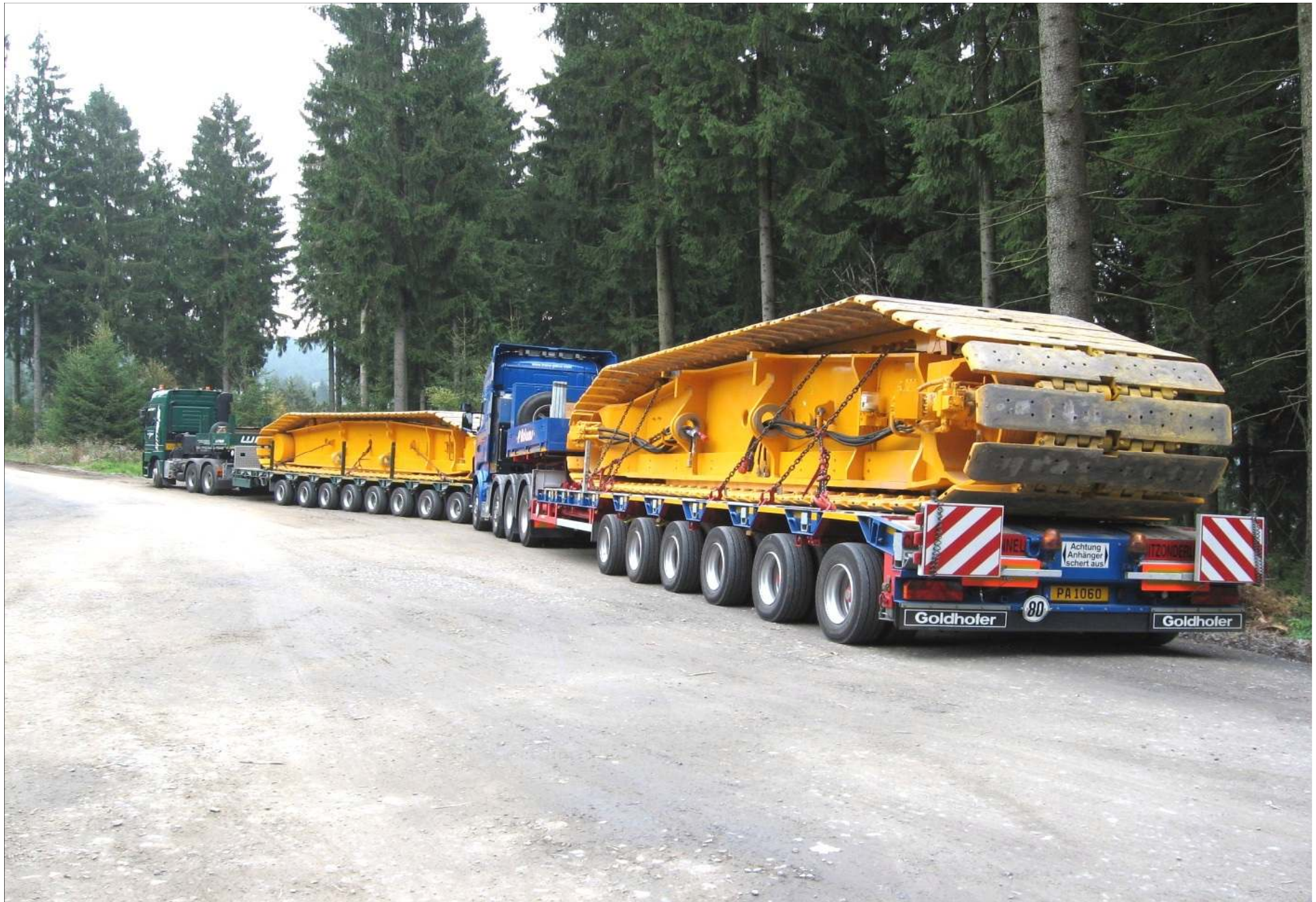
Das Fahrwerk der Kranraupe wird angeliefert
