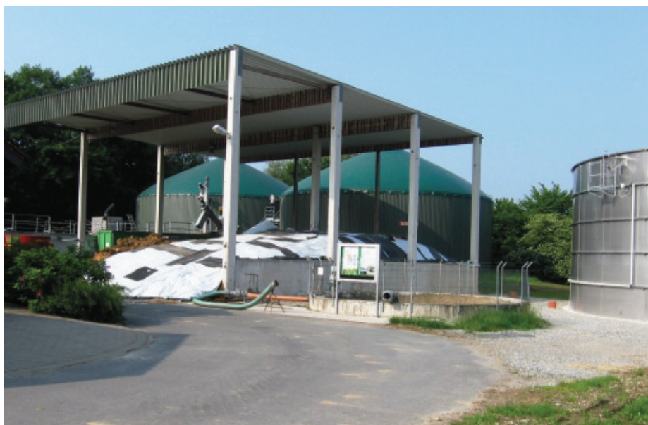
Abbildung VI / 7: Ansicht der Biogasanlage Haus Düsse
